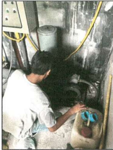
รูปภาพที่ 2.35 เครื่องเติมอากาศระบบบำบัดน้ำเสีย
